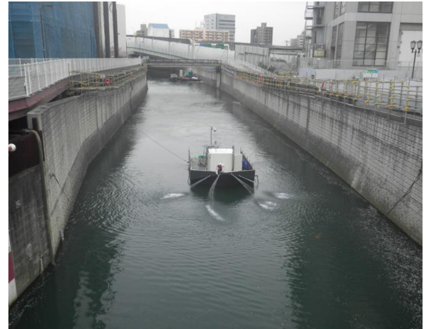
設置後 稼働の様子
